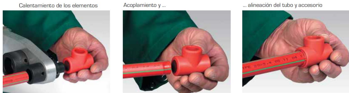
Figura 1. Soldadura con termofusión (unión por enchufe)
