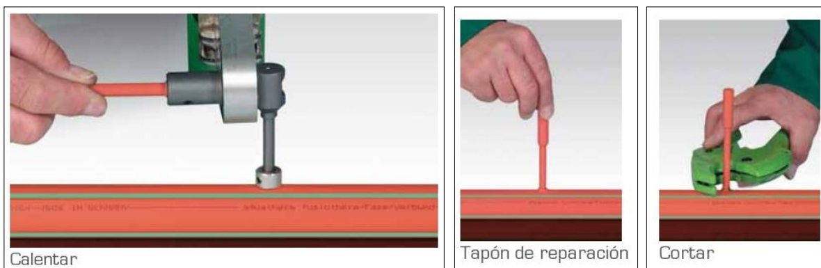
Figura 4. Reparación con varilla
