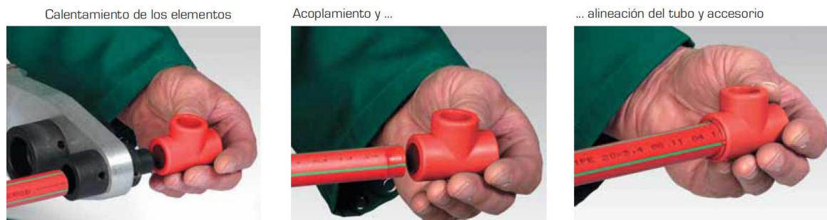
Figura 1. Soldadura con termofusión (unión por enchufe)
