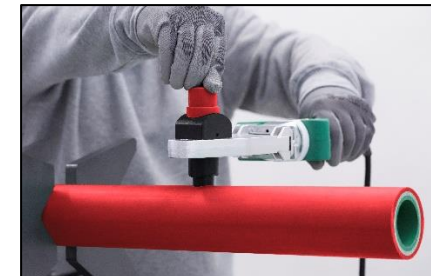
Figura 9. Calentamiento con matriz para derivaciones soldables.
