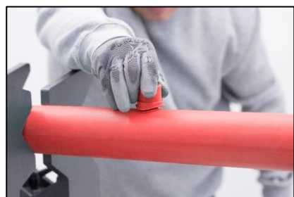
Figura 10. Aplicación de la presión necesaria para la correcta fusión.
