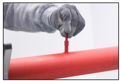
Figura 11. Tapón de reparación en la tubería.
