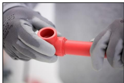
Figura 4. Para fusionar los elementos se mantiene la presión el tiempo mínimo recomendado.
