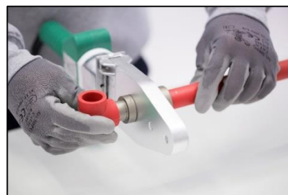
Figura 3. Aplicación de calor al tubo y al accesorio mediante las matrices correspondientes.
